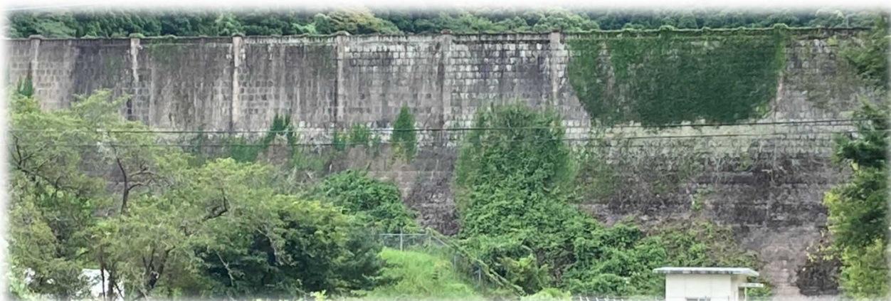
写真-2 転石ダム
